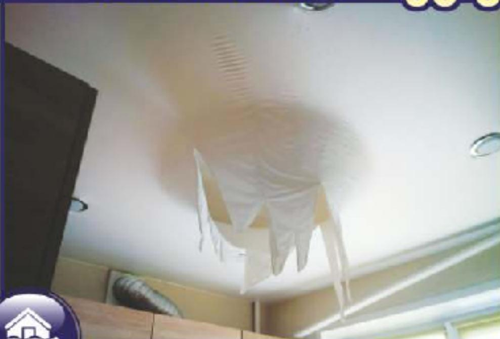
В квартире лопнул шланг сливного бака. Вода затопила квартиру этажом ниже. Пострадали натяжной потолок, потолочный светильник, ламинат и обои.
