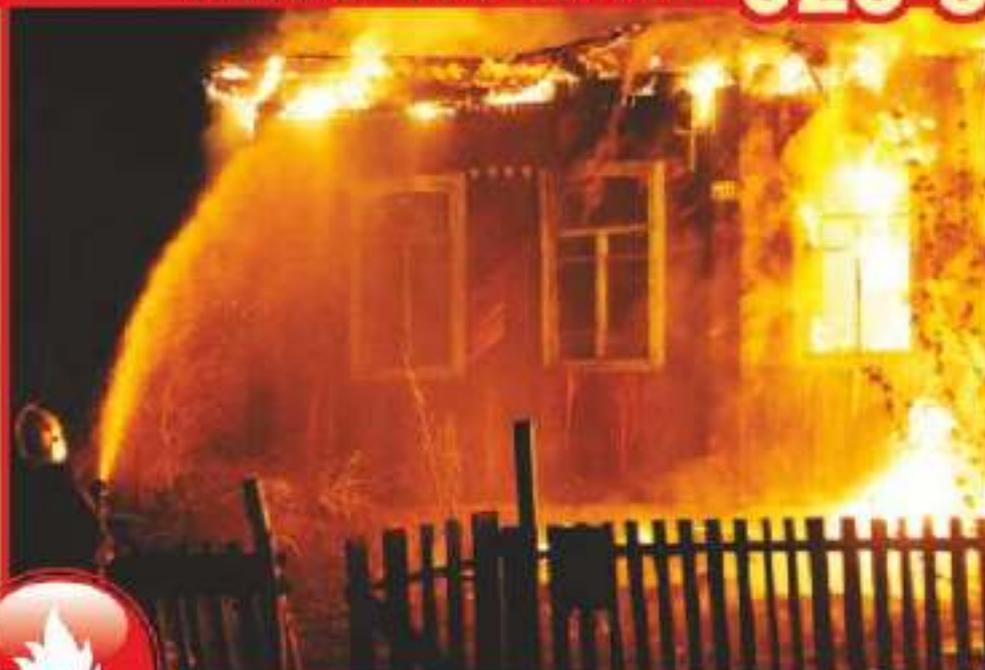
В д. Александровка в окрестностях г. Киевляк произошел пожар в одноэтажном жилом доме. Причина – самовозгорание электропроводки на веранде. В результате пожара сгорела и обрушилась обрешетка крыши, обгорели стены, перегородки, перекрытия.
