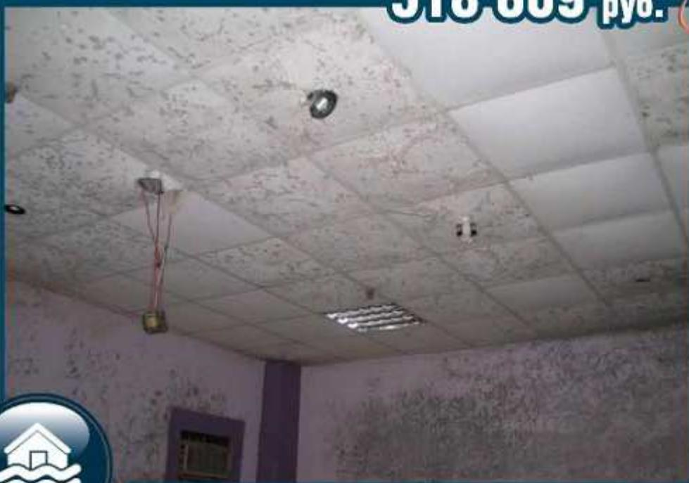
В октябре 2014 г. совершена выплата в связи с затоплением канализационными водами офисного помещения, расположенного на первом этаже жилого дома. Причина затопления – засор канализационного выпуска жилого дома. Пострадали офисная мебель, техника и отделка стен, потолка и пола.
