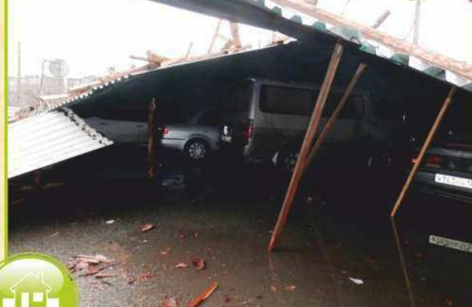
В июле 2012 года выплачено страховое возмещение предприятию «Томский лакокрасочный завод» в связи с ущербом, причиненным ураганным ветром. Сильным порывом ветра со здания завода было сорвано покрытие кровли, стропильная система утеплитель.
